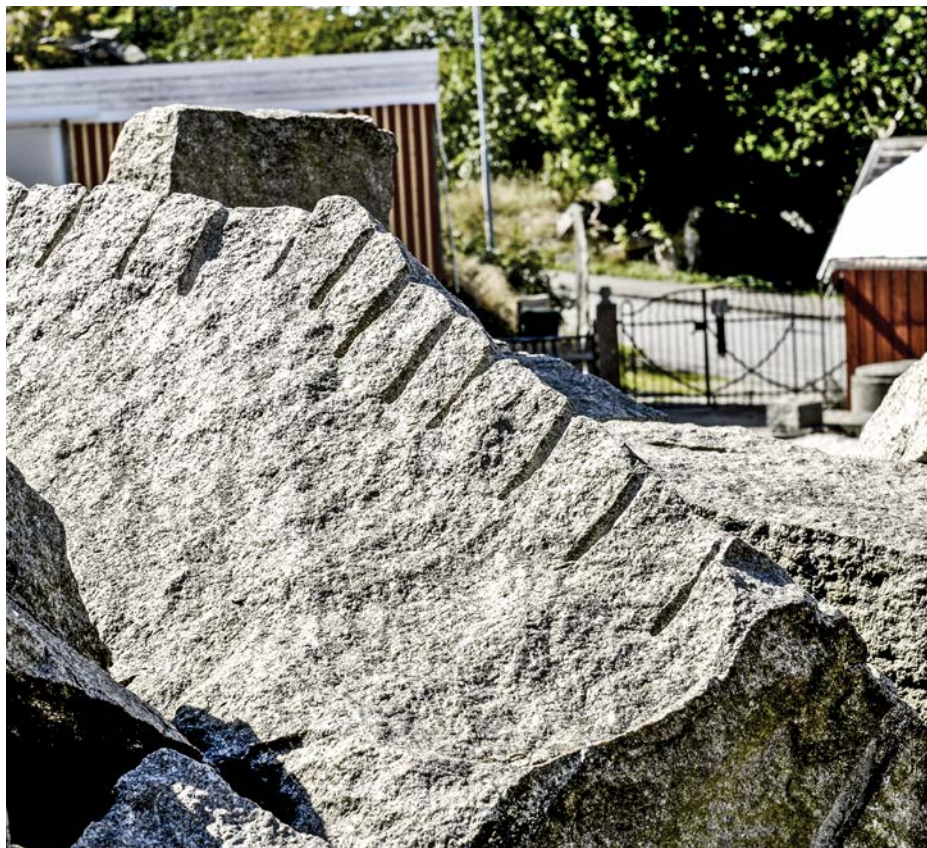
Har du en gammal husgrund med stora stenblock? Kolla om du hittar brytspåren, som visar var stenhuggare slagit ner sina borrar i stenen. Handhuggen sten – ett tecken på kvalitet!
